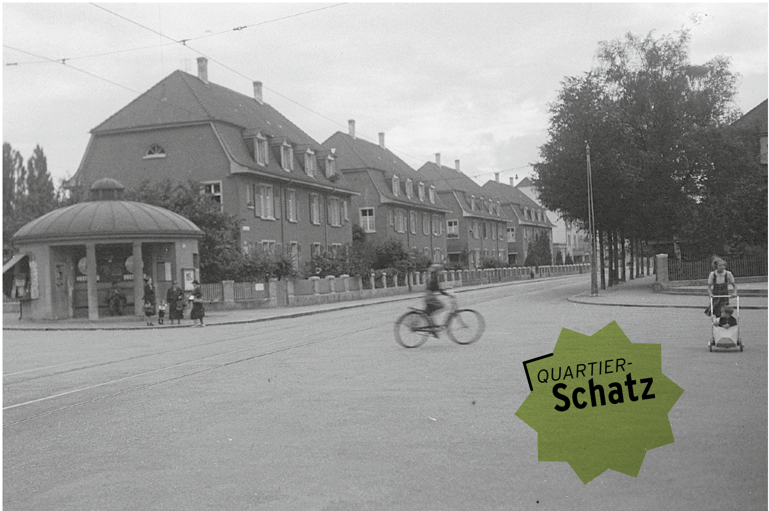
Foto: Tramwartealle und Reglerstation, Neuweilerplatz 6; Neuweilerstrasse 1-15, 1938, Staatsarchiv Basel-Stadt, NEG 8444
